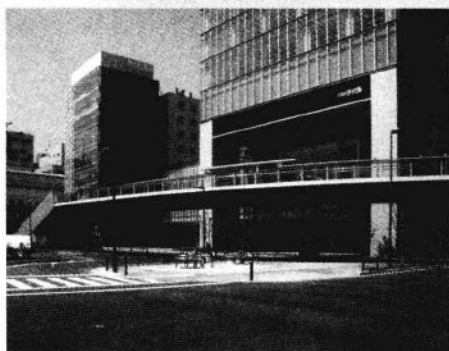
图6.1 使用高强度混凝土的人行过街天桥 （照片提供：鹿岛建筑有限公司）
