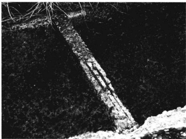
图5.8 温泉地带的混凝土劣化
